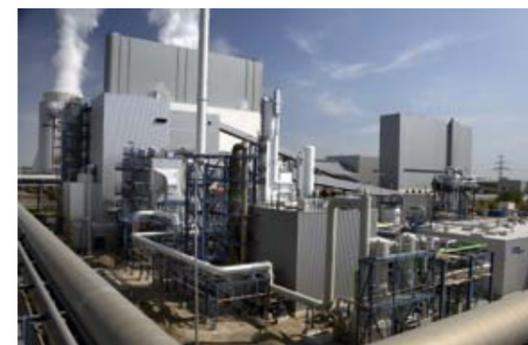
Oxyfuel Pilotprojekt Schwarze Pumpe von Vattenfall. Ausgestattet mit REITZ Ventilatoren entsteht das erste CO<sub>2</sub>-freie Braunkohlekraftwerk der Welt. Foto: Vattenfall, Berlin
